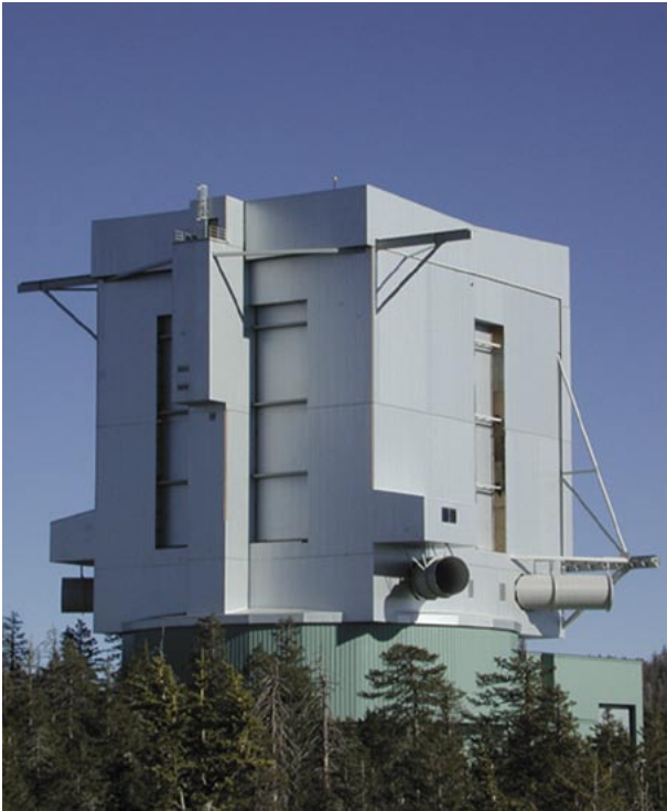
Abb. V.1.2: Das Gebäude des LBT.
